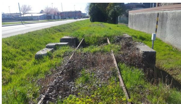
sedime ferroviario adiacente area residenziale
