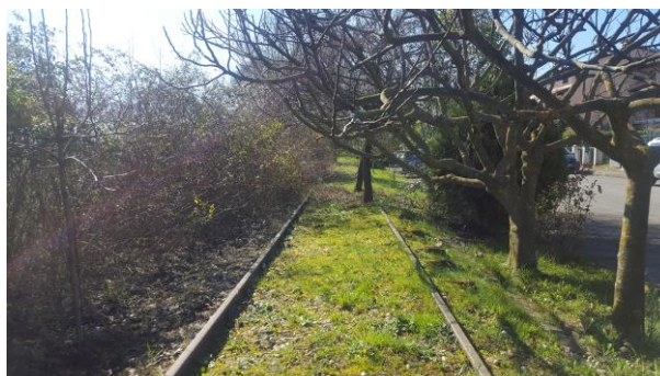
sedime ferroviario adiacente area residenziale
